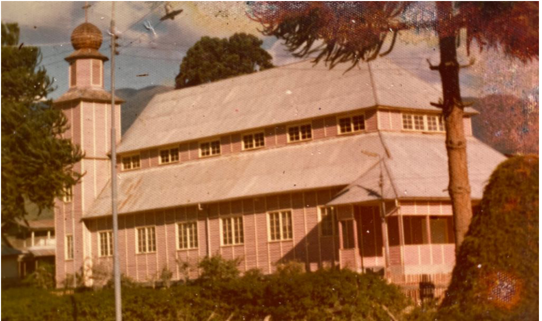
Iglesia Matriz "Santa Rosa" en Oxapampa. Fue construida en 1939 a base de madera y por colonos alemanes. | © Familia Schipper Böttger „Santa Rosa“ Kirche in Oxapampa. Sie wurde 1939 von deutschen Siedlern aus Holz gebaut. | © Familie Schipper Böttger
